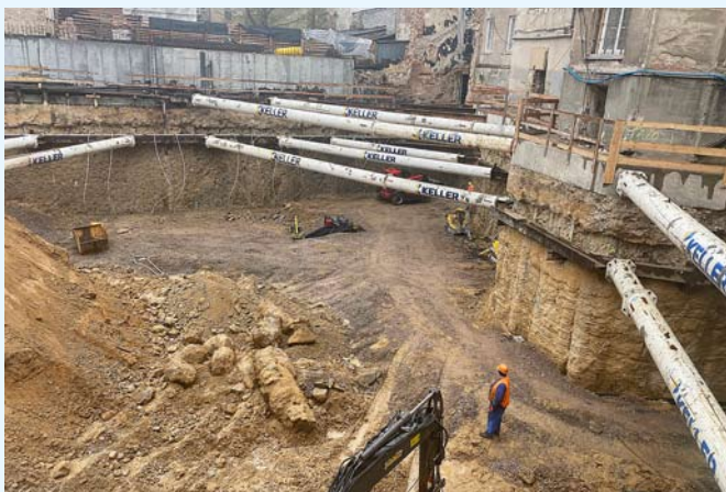
• Budowa kondygnacji podziemnych Teatru im. Stefana Żeromskiego.
