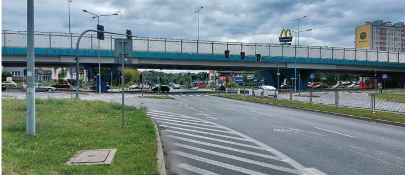
► Wiadukt w ciągu ulic Żelaznej – Armi Krajowej projektu doc. Marcelego Dziurli.
