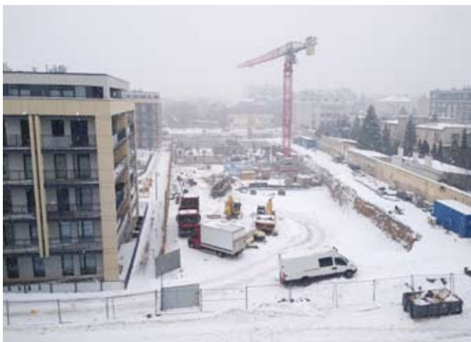
► Trwają prace przy betonowaniu płyt na Osiedlu Legionów.
