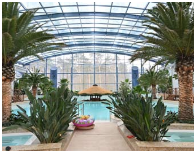
► Rozsuwany szklany dach nad parkiem wodnym waży prawie 300 ton.
