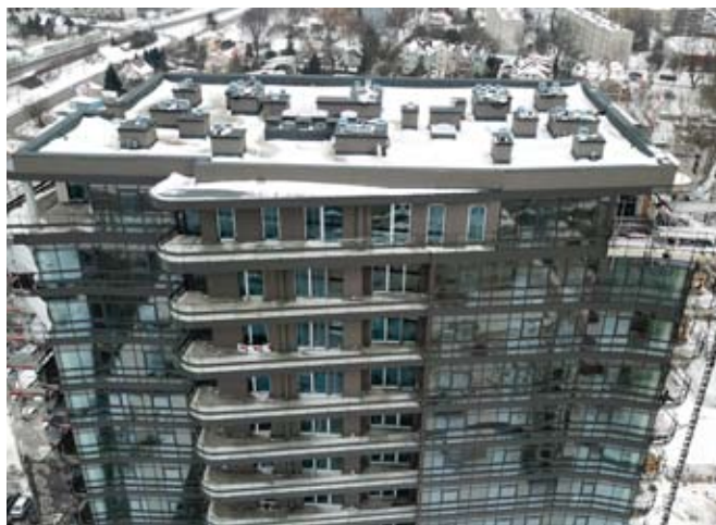
► W Plaza Tower ekipy pracują we wnętrzu obiektu.
