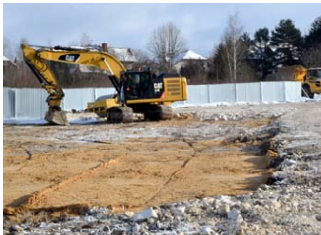
► Na budowie GUM organizowany jest plac budowy.
