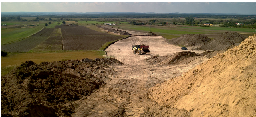
Dobiegają prace związane z odhumusowaniem pasa drogowego.
